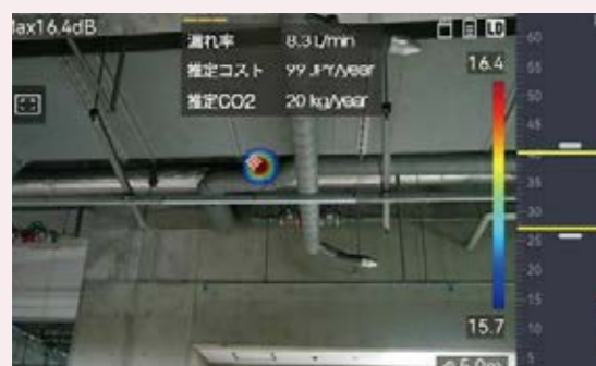
空気漏れの推定漏れ量と損失額、推定CO 2 を表示
